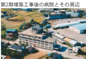
第2期増築工事後の病院とその周辺
