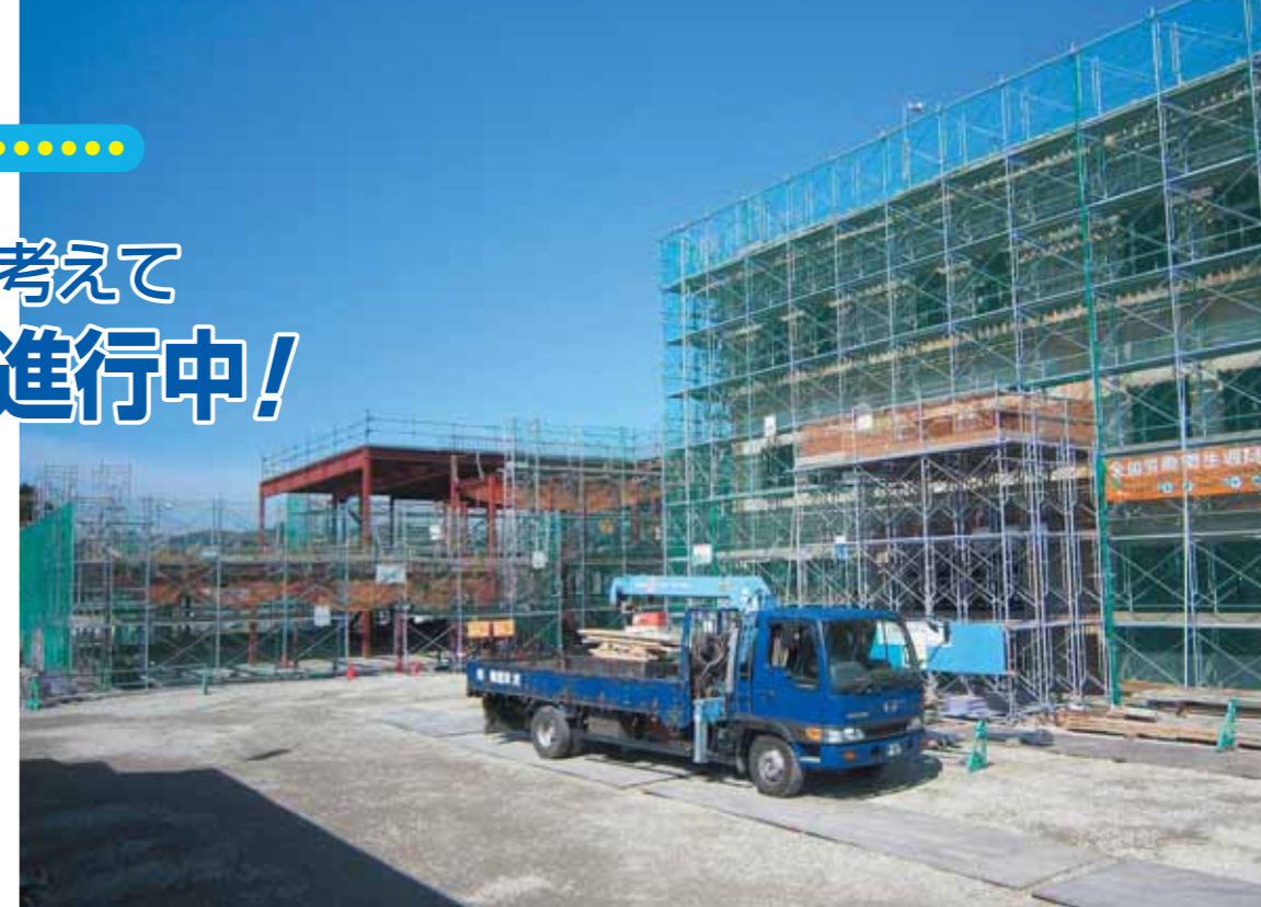
秋空のもと、鋭意進行中の建設現場。手前右側は4階建て鉄筋コンクリート造の「西能病院」、左奥が2階建ての鉄骨造、「整形外科センター西能クリニック」。9月末時点の進捗率は26%で、これから設備・内装工事へと掛かっていきます。
