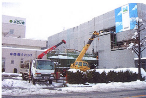
▲雪の中、建設は順調に進んでいます
