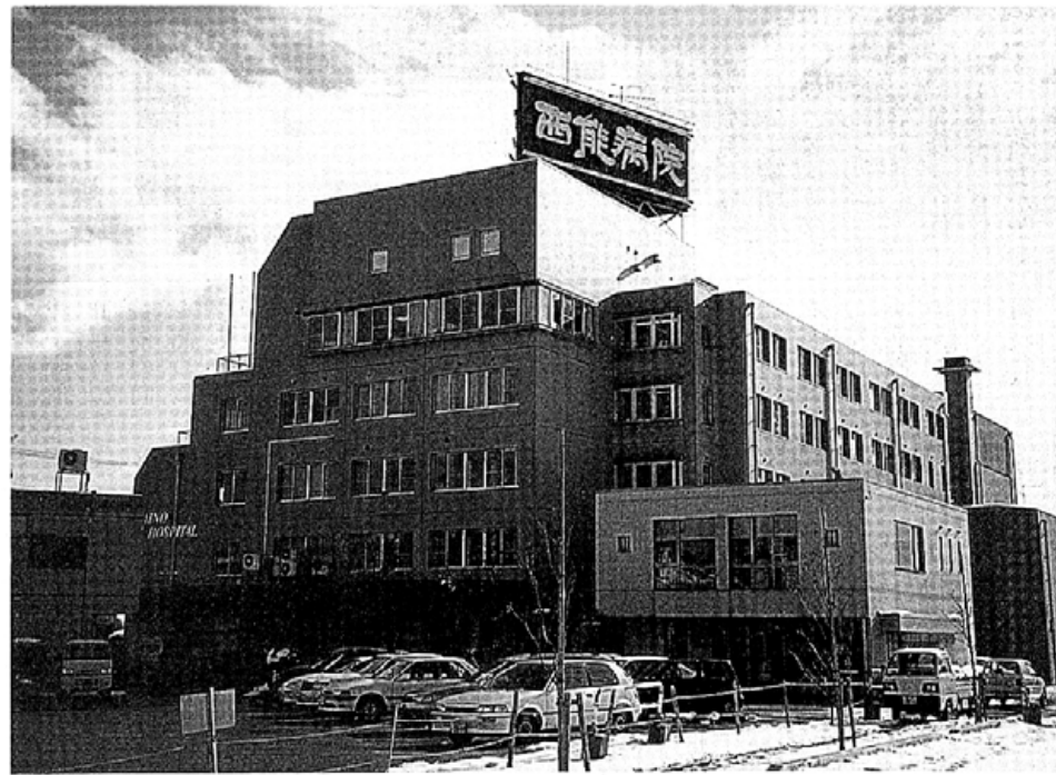
都市計画道草島線（一部開通）から、38年を刻んだ西能病院をのぞむ
