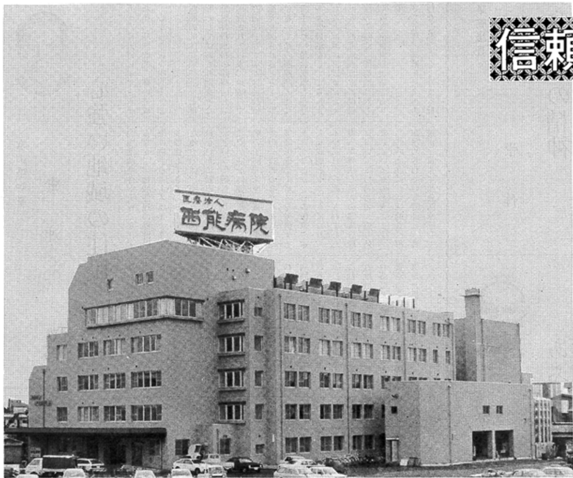
新装・明るく快適な西能病院＝北側から見た病院全景
