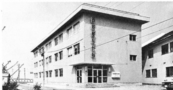
昭和40年4月、第1期増改築工事が完了
